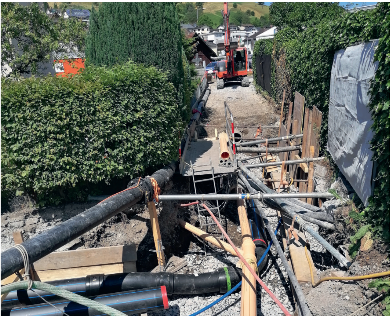
Netzarbeiten im Seefeld
