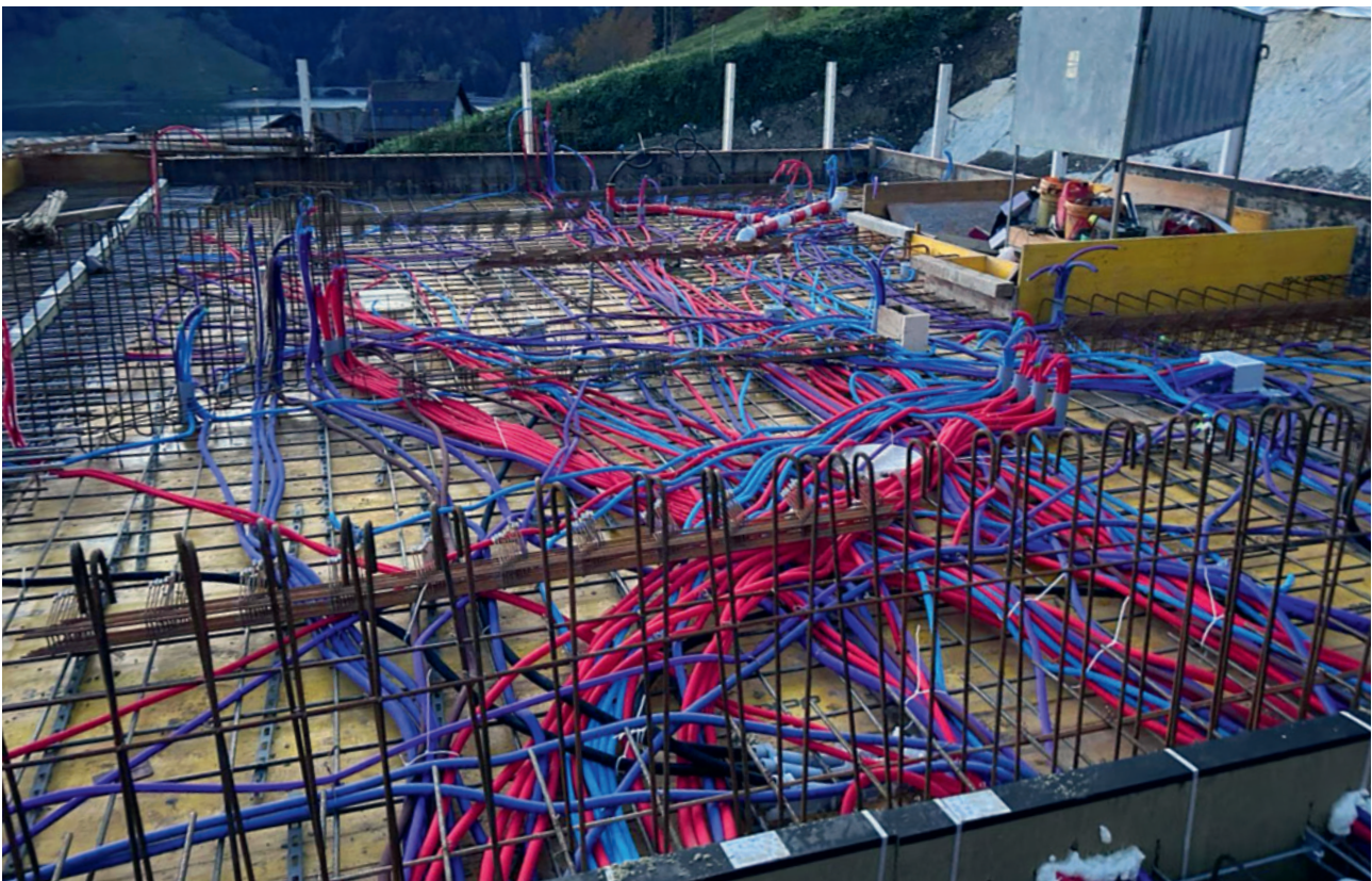
Elektrorohre in Bodenplatte
